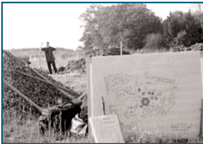
Výstavba parku v Ořechu.
