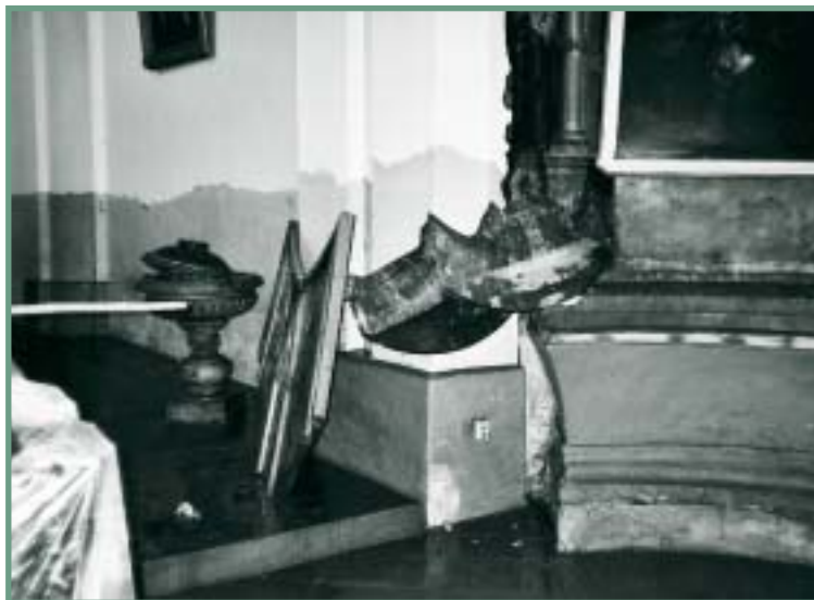
Voda opadla – interiér kostela sv. Šimona a Judy ve Štětí.
