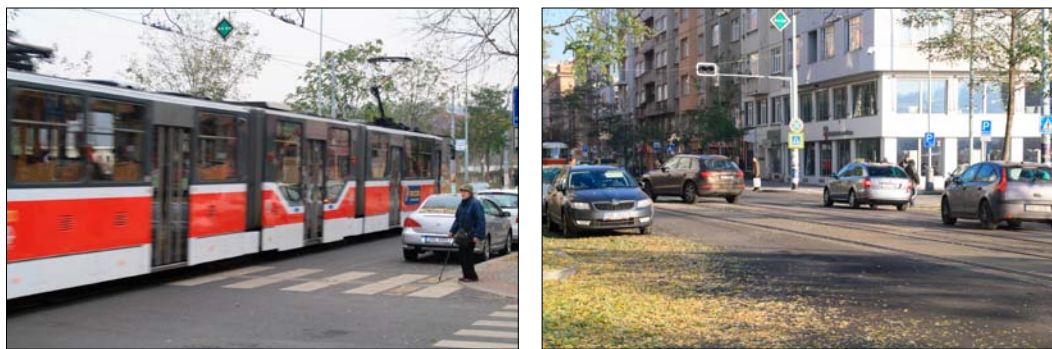
Obr. 16: Přechody na křižovatce Komunardů x Tusarova neumožňují bezpečné přecházení, vozovková plocha je zbytečně velká a nejsou zajištěny dostatečné vzájemné rozhledy
