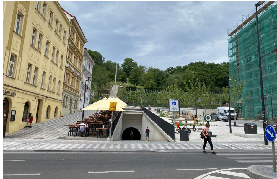
Revitalizace Tachovského náměstí v Praze, OVA, 2023
